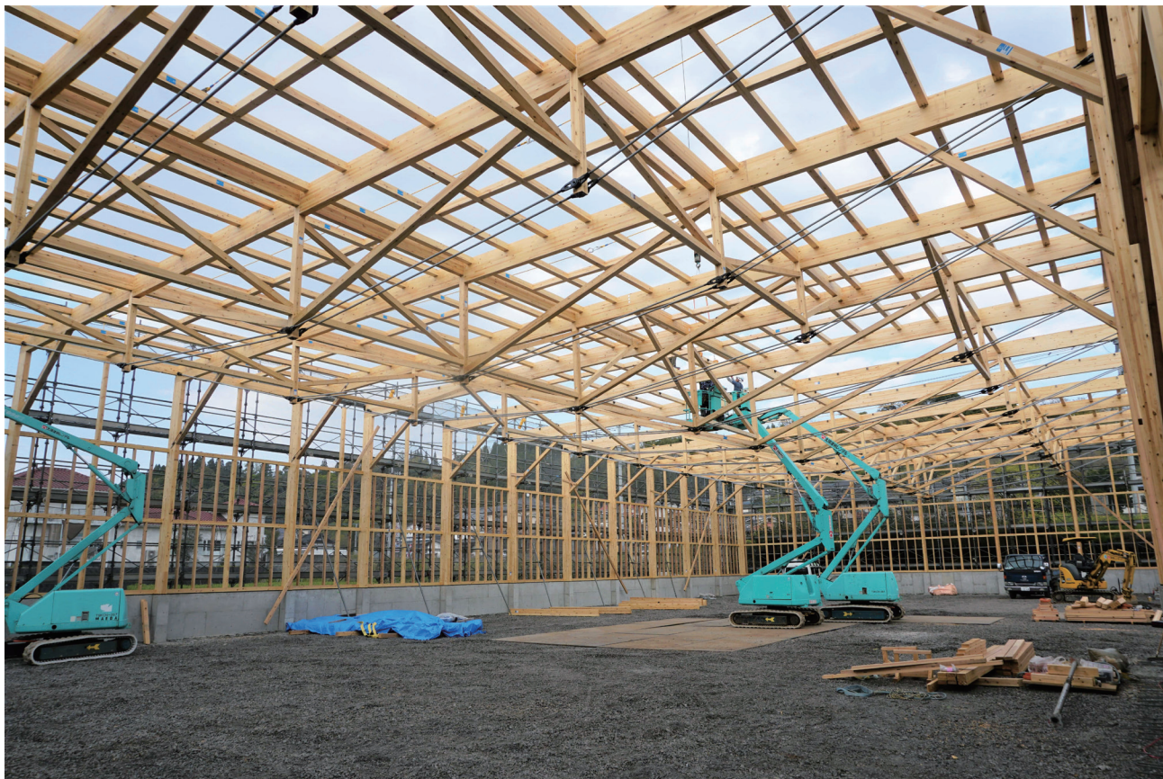
ATAハイブリッドトラスの施工 スパン 24 m x 8 フレーム、21 m x 4 フレームの計 12 フレーム
