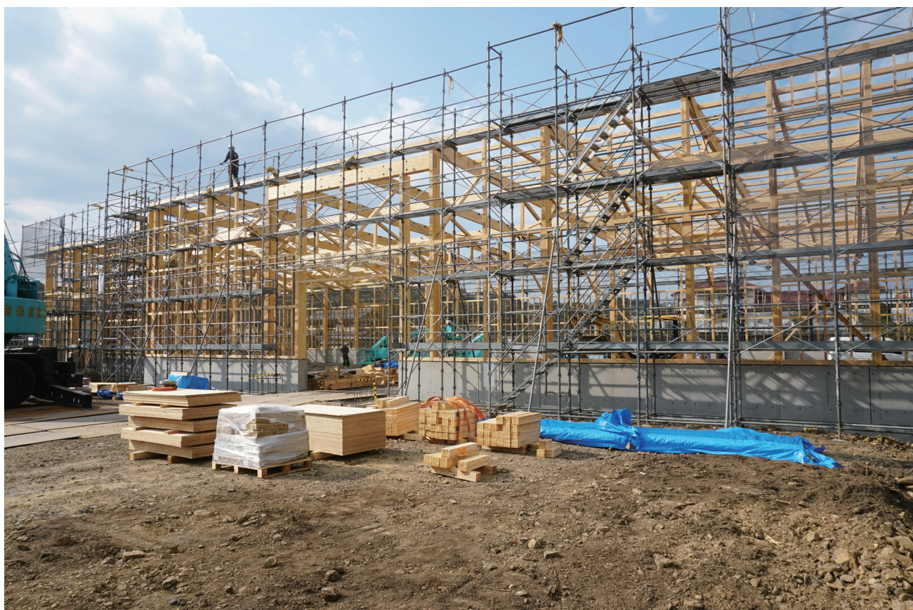
床面積 1,060 平米（321 坪）のホームセンターの建て方工事（4 月 13 日）
